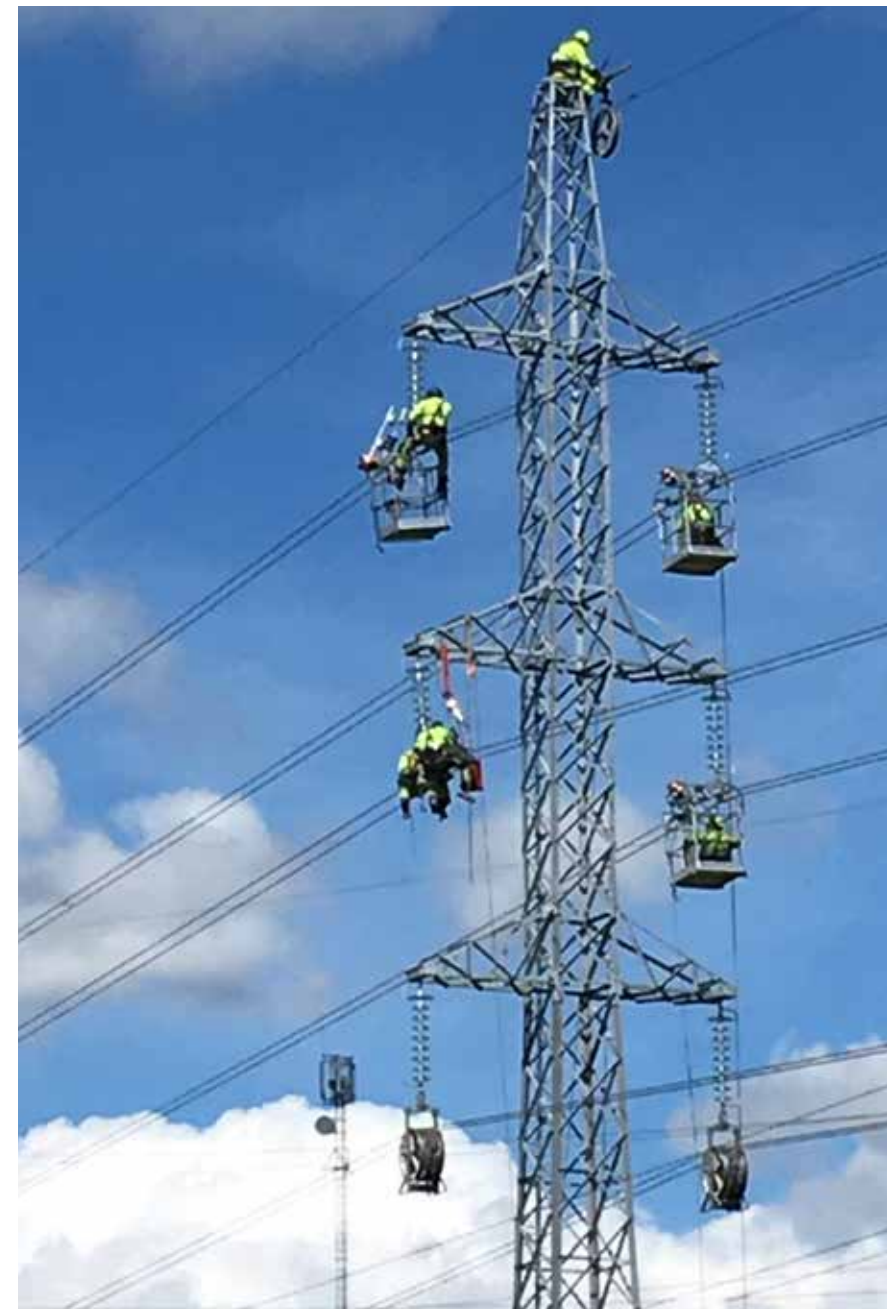
110 kV liini ehitamine Pärnumaal
